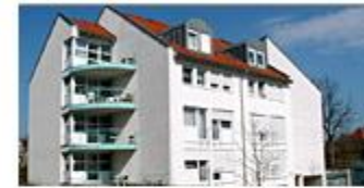
Wohnheim AA-Unterrombach, Steinertgasse 10
